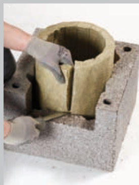
Aseta vill mantelplokki ning tee sisselõige puhastustoru jaoks.
