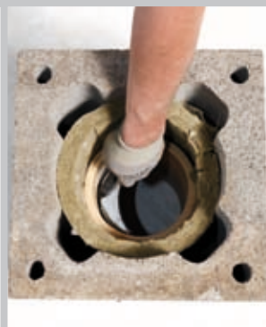
Paigalda šamottoru ning paigalda väike tahmaluuk. Märgi väikse tahmaluugi „sabale” õige pikkus.
