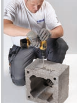
Korrektse ava saamiseks puuri alumisse äärde augud. Mantelploki ava ja šamottoru ava vahele peab jääma 2 cm vahe villa jaoks.
