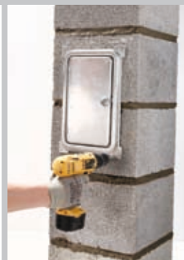
Puuri tahmaluugi paigaldamiseks augud ning kinnita tahmaluuk kompleksis olevate naeltüüblitega plokki külge.
