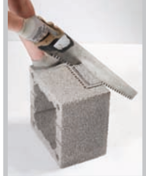
Lõika mantelploki ava kõvasulamhammastega saega.
